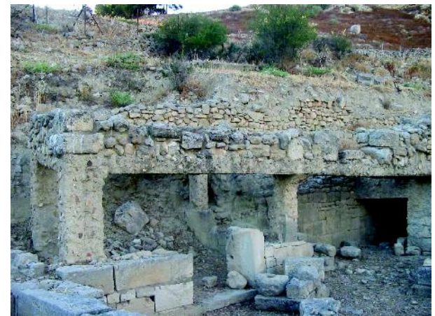
Chalara, struttura tardo antica ricostruita su scheletro in cemento armato
