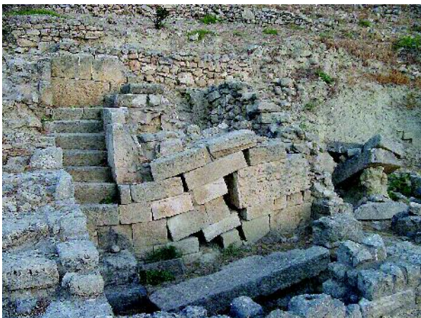
Chalara, area interessata da crolli antichi (terremoto)
